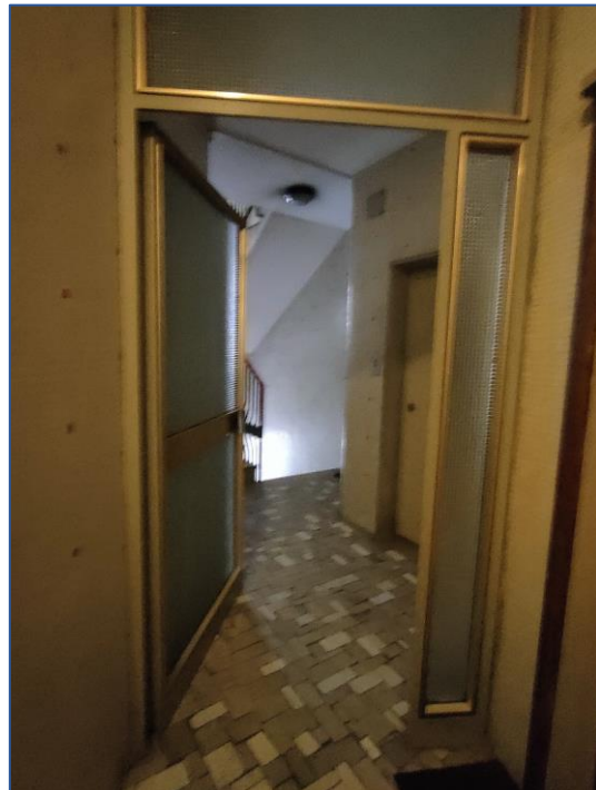
Foto 4 - vano scala comune
