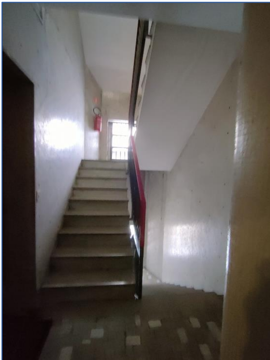
Foto 3 - vano scala comune
